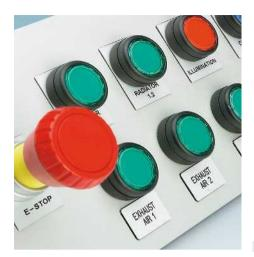
Los marcadores sin fin autoadhesivos EMLP (Ex...)R ... son ideales para marcar interruptores automáticos y cubiertas de carcasas en cajas de conexiones domésticas
