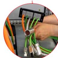
Entrada de cables con conectores hasta diámetros de 35 mm (KEL-U24/KEL U-16)
